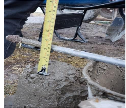
Figura 3. Medición de Slump
