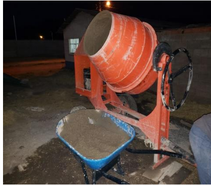
Figura 2. Vaciado de Concreto
