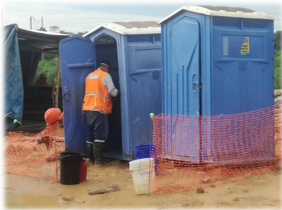
Figura 16. Limpieza y disposición final de residuos líquidos de baños portátiles por una EPS
