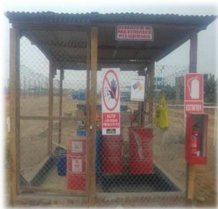
Figura 17. Almacén de materiales y sustancias peligrosas.
