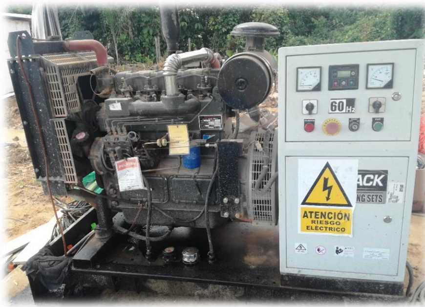
Figura 13. Mantenimiento del grupo electrógeno.
