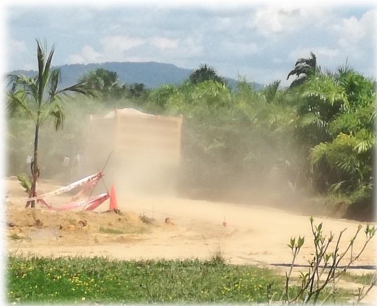
Figura 9. Generación de material particulado en la actividad de movimiento de tierra
