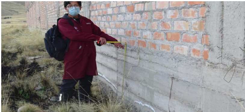
Foto 08. Medición de la altura del sobrecimiento Fuente: Elaboración del equipo de trabajo
