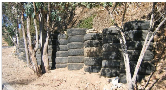
Figura 4. Protección de un camino mediante muros de llantas recicladas.
