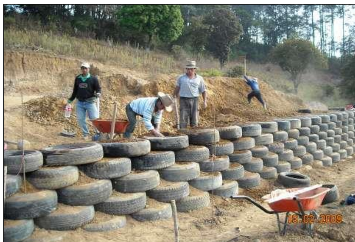
Figura 2. Colocación y compactación de las llantas.
