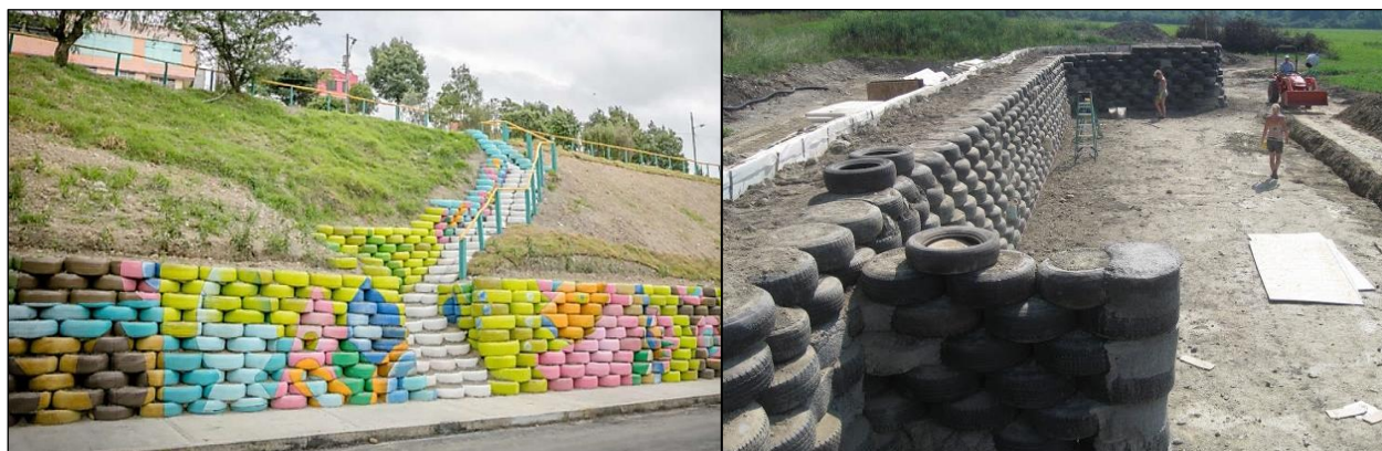
Figura 1. Muros de llantas reciclados cumpliendo la función de estabilizar taludes.
