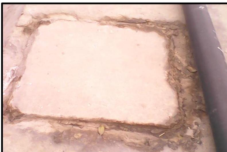
**Figura 28 – Tapa de sellado, ubicada en la parte superior de la campana de gases.**
