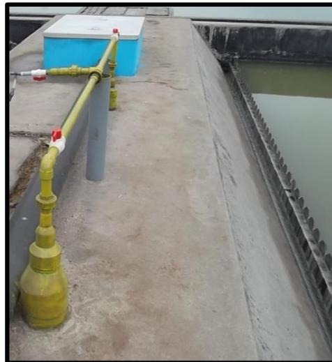
Figura 59 – Válvula de salida de biogás, punto de monitoreo
