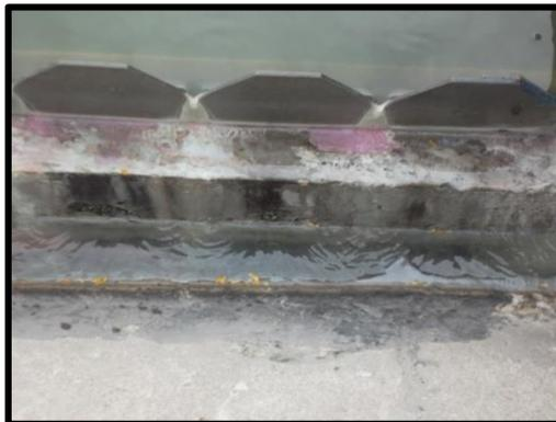
**Figura 33 – Microorganismos desarrollados sobre la canaleta De recolección – agua tratada por el reactor UASB.**
