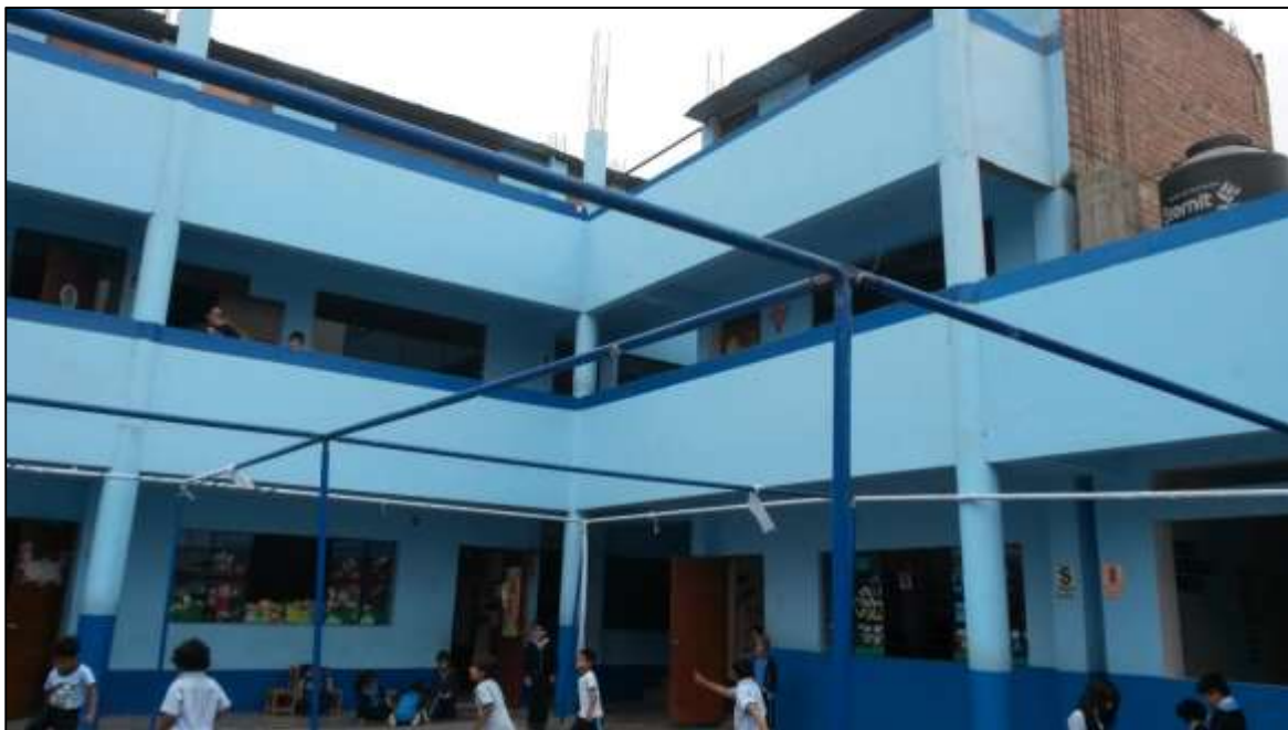
Figura 35. Infraestructura del colegio "Mi Jesús".
