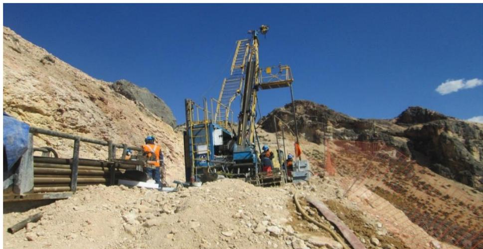
*Figura 10.* Trabajos con perforación diamantina.
